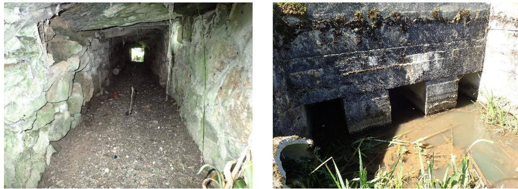
Figure 10 : Ouvrage hydraulique situé en aval de l'étang de la Vézérie
