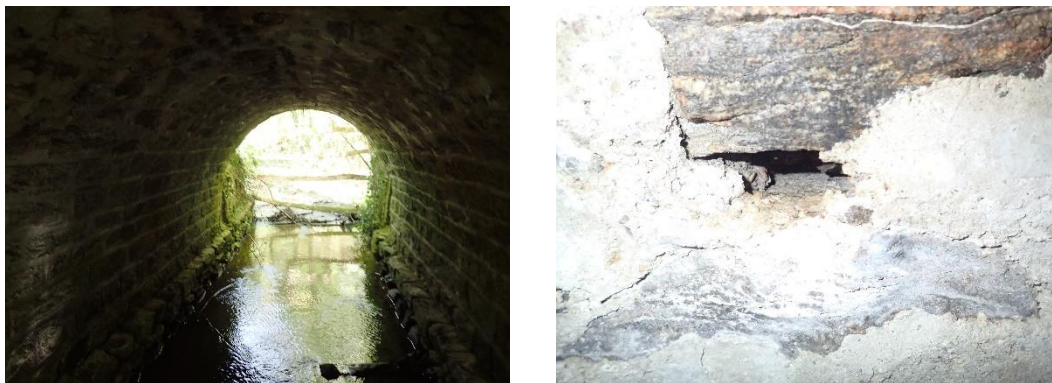
Figure 11 : Ouvrage hydraulique situé au niveau du Verdier
